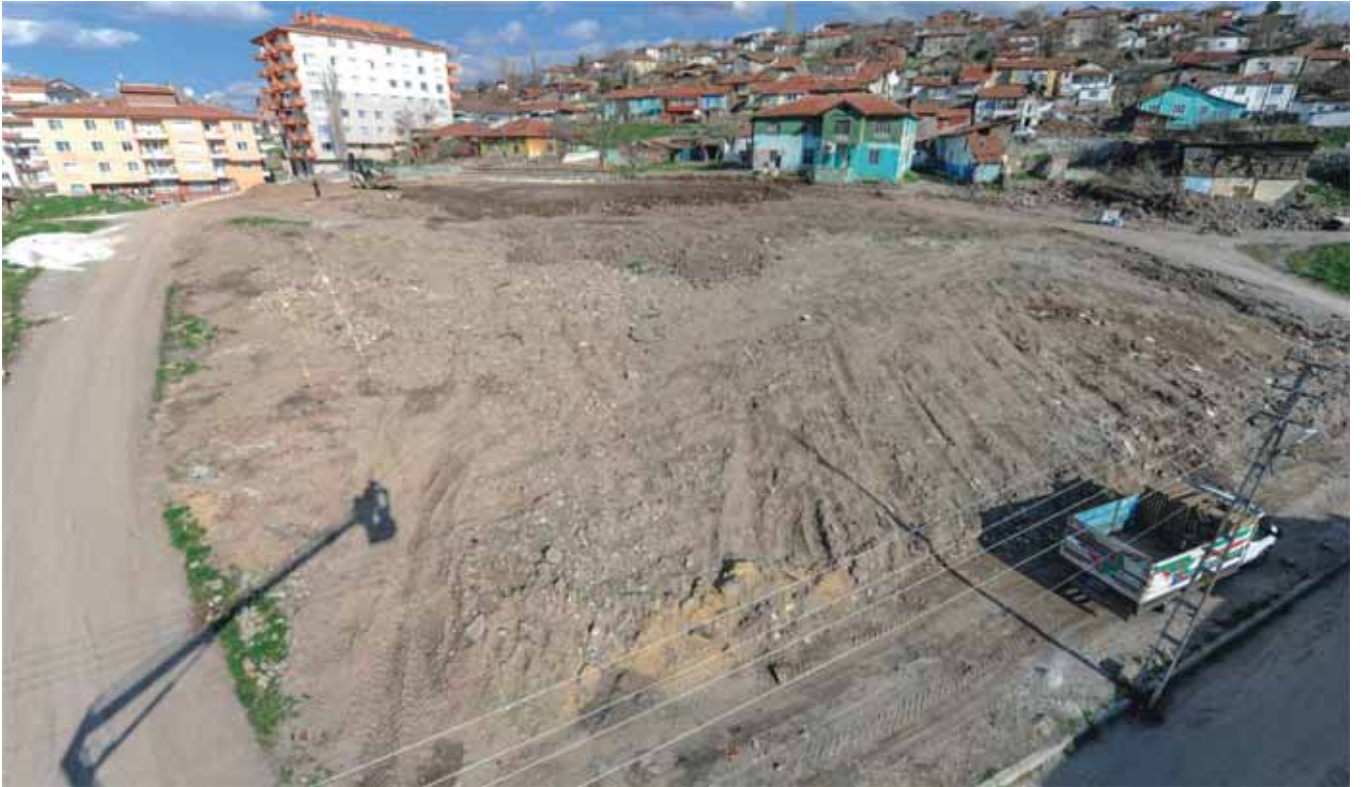
Plevne Mahallesi Park İnşaatı
