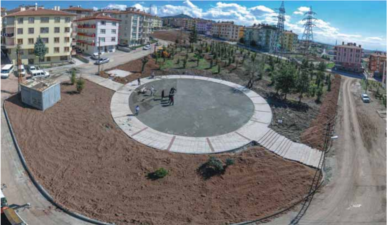
Alemdağ Mahallesi Park İnşaatı
