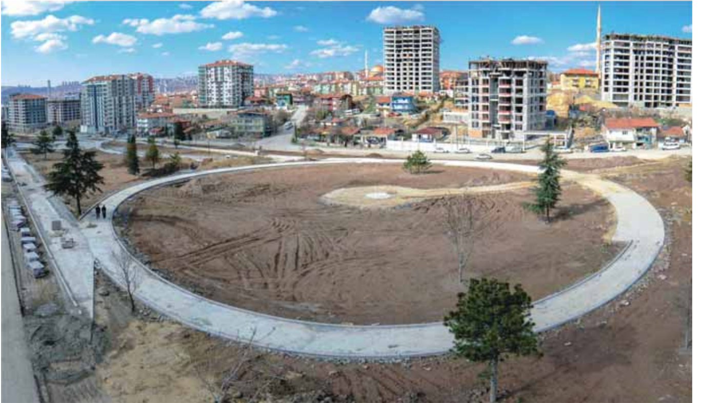
Ali Ersoy ve Yıldıztepe Mahallesi Park İnşaatı
