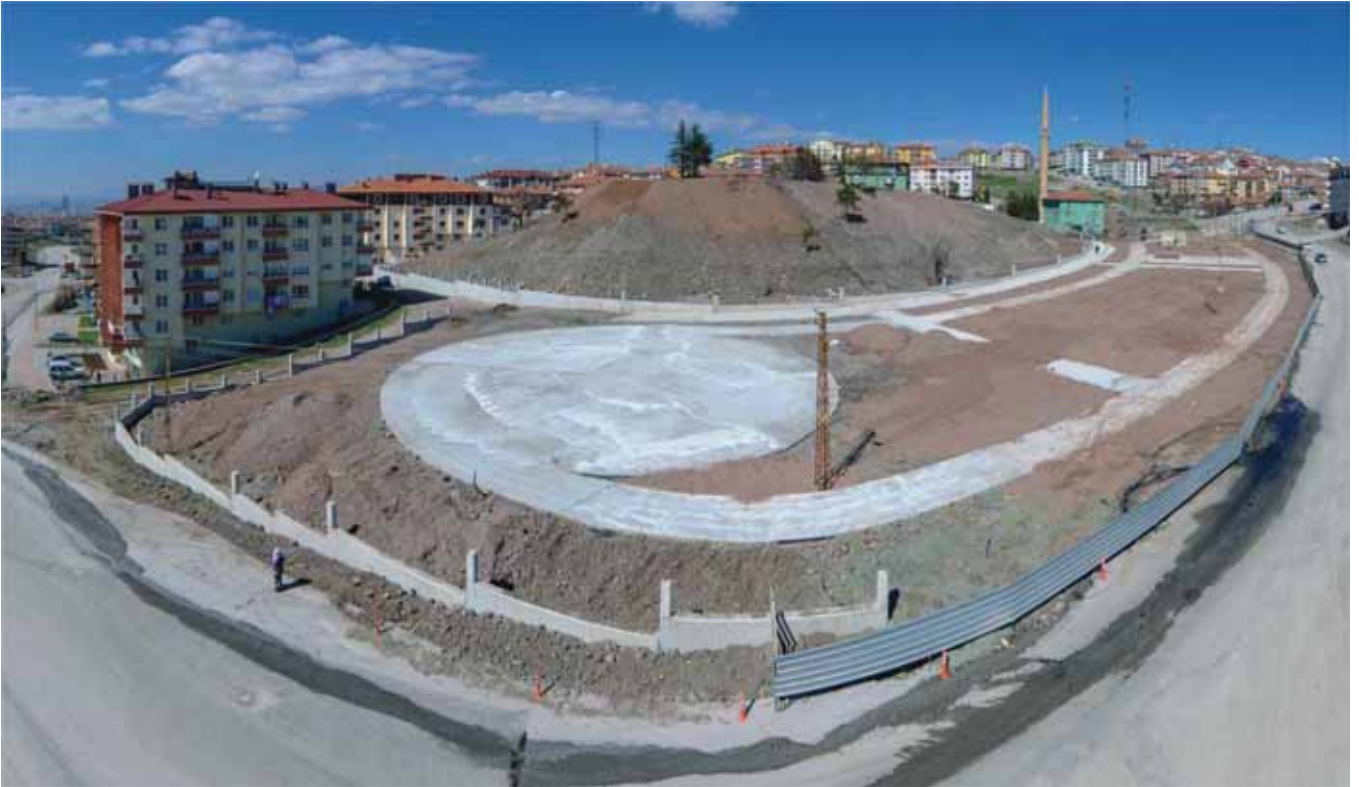
Çamlık Mahallesi Park İnşaatı
