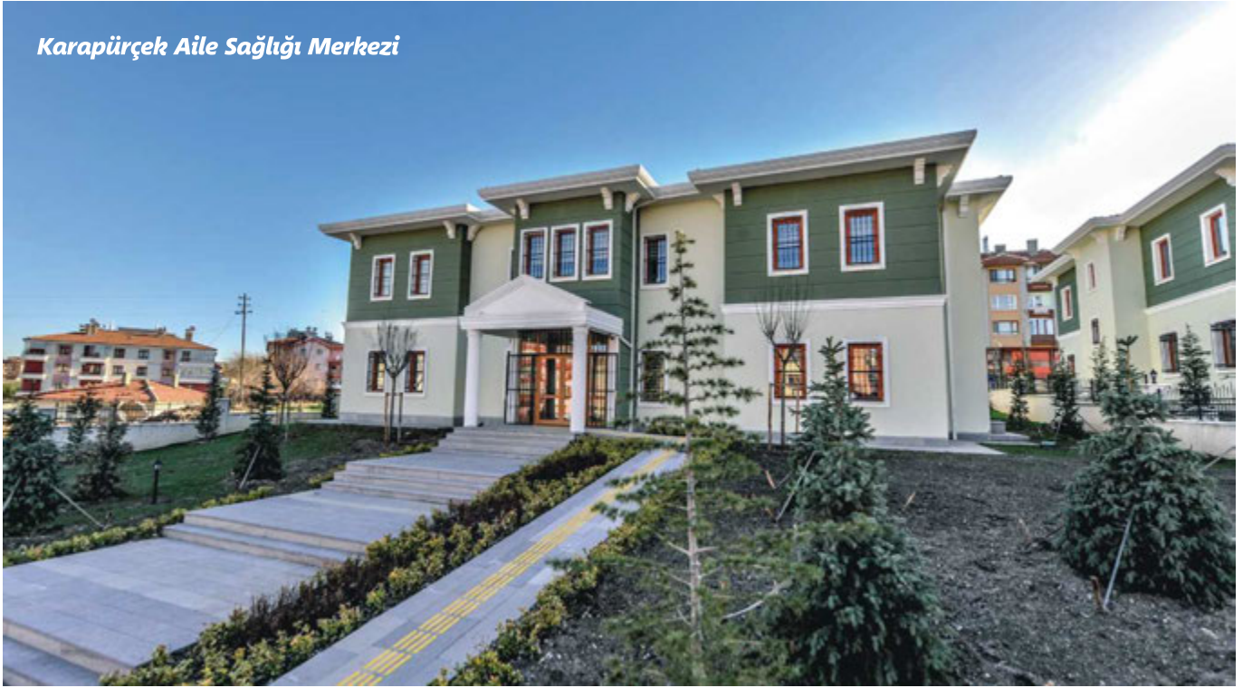
Karapürçek Semt Hizmet Binası
